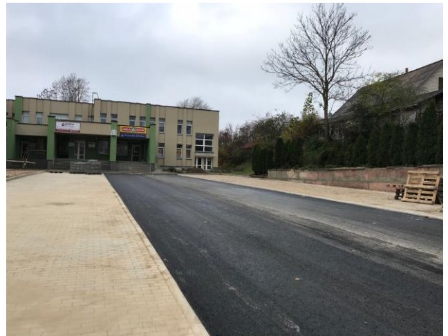
PSPC aikštelė prieš po asfaltavimo
