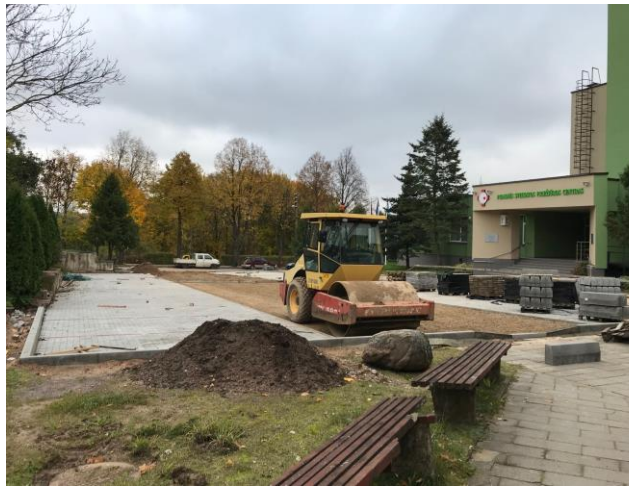
PSPC aikštelė prieš asfaltavimą
